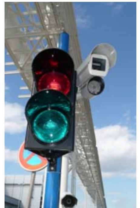
Kamera na sloupku odjezdového semaforu
