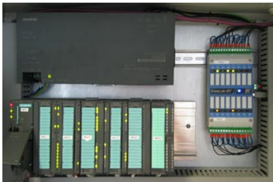
Software vizuální inspekce přímo ovládá jednotku DataLab IO
